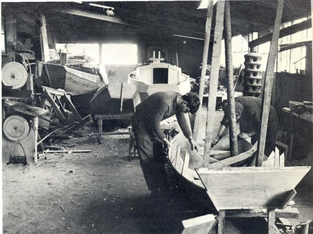
Nieuwe schouwen in aanbouw.
