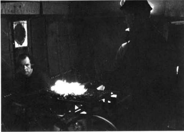
Tijdens het verhitten liggen de nagels in een soort roostertje dat tussen de kolen inligt. Het is zeer belangrijk dat de nagelheter de nagels op tijd uit het vuur haalt. Als een nagel verbrandt is hij onbruikbaar geworden.
