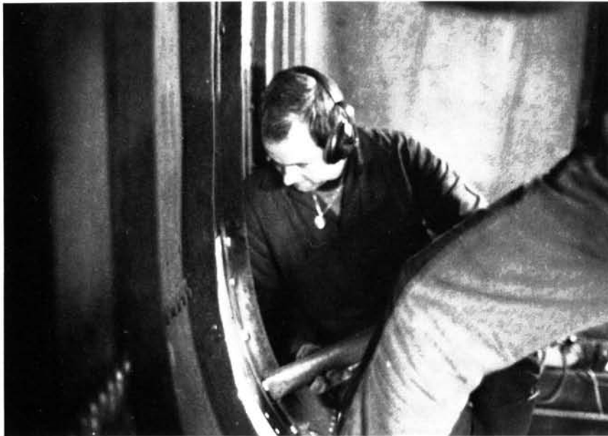
Zodra de nagel verschijnt geeft de klinker met de luchthamer een „roffel” op de randen van het gat om de platen tegen elkaar aan te drijven. Dan
