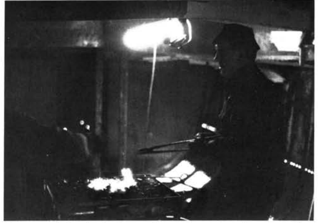
Een grote behendigheid met de nageltang is nodig om een hete nagel in de kortst mogelijke tijd van het vuur naar de tegenhouder te transporteren.
