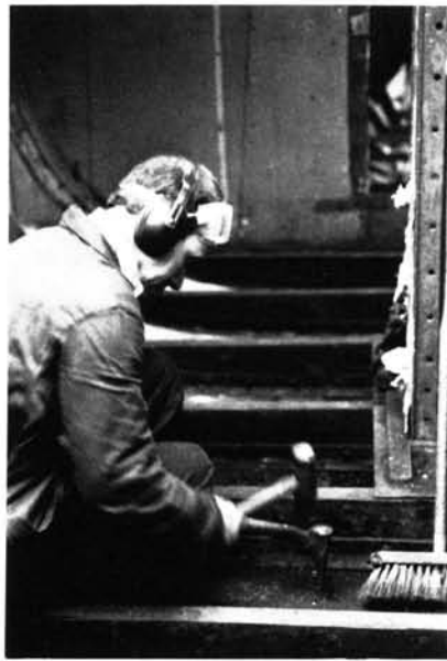
De oude klinknagels worden uitgedreven met een „por”
