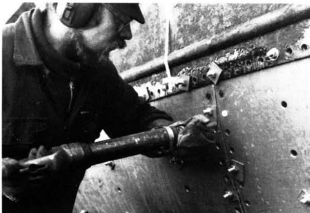
Zodra de nagel verschijnt geeft de klinker met de luchthamer een „roffel” op de randen van het gat om de platen tegen elkaar aan te drijven. Dan
