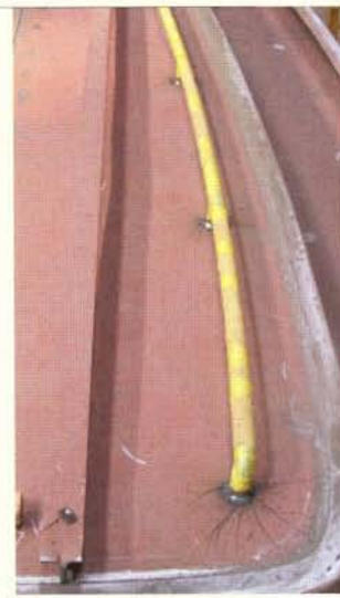
De handreling wordt op het kajuitdak gelast.
