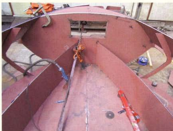
De kuip krijgt al vorm en er komt verband in het achterschip.
