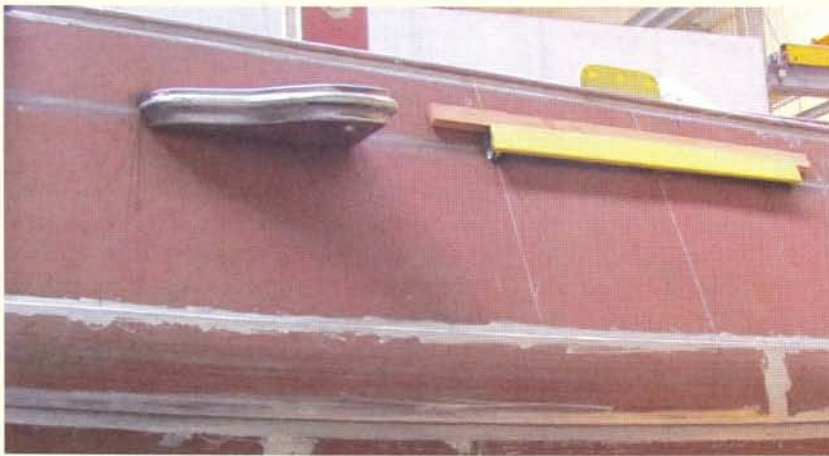
Bij de bouw van een casco moet overal aan worden gedacht. Aanvaringsklampen, bevestiging voor de zwaardophanging, voordat er geschilderd kan worden, moet al het laswerk zijn afgerond.
