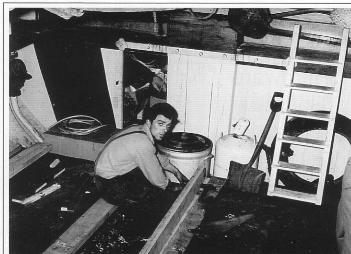
Duijvendijk jr. bezig met het dichtmaken van de keel.
